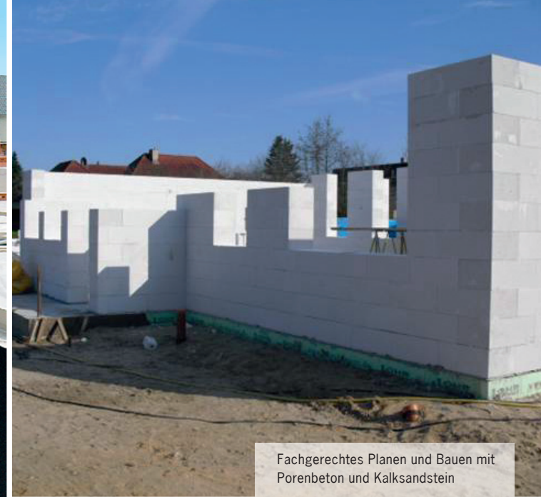
Sockelausbildung in Zusammenhang mit der Bauwerksabdichtung
