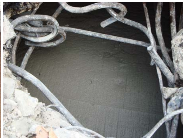
Bild 12: Ausbetoniert Hohlräume
