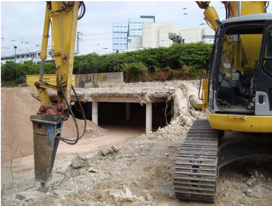
Bild 10: Kellerräume mit Verfüllmaterial
