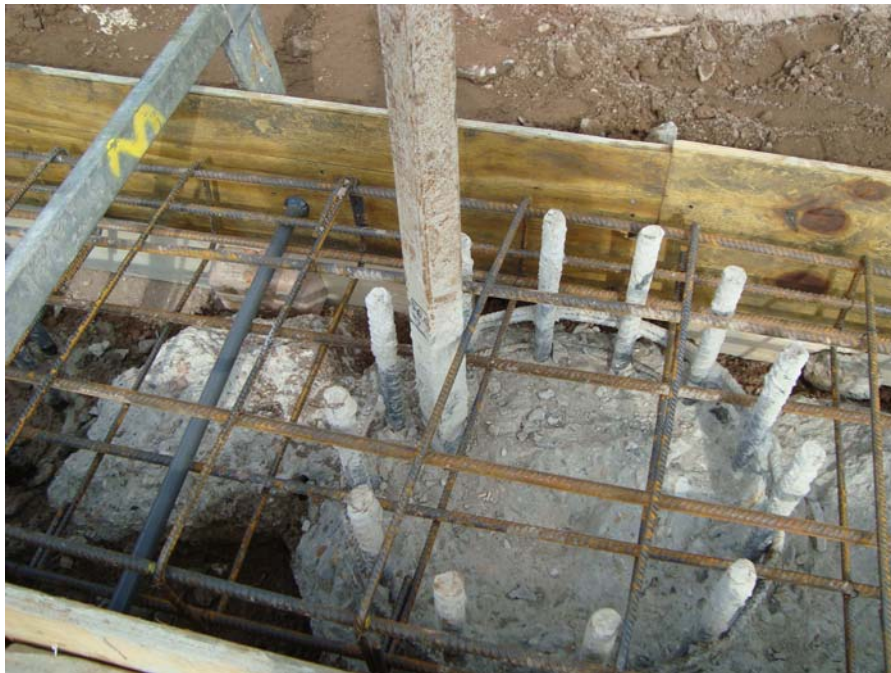
Bild 4: Bewehrungskorb mit Inklinometerrohr
