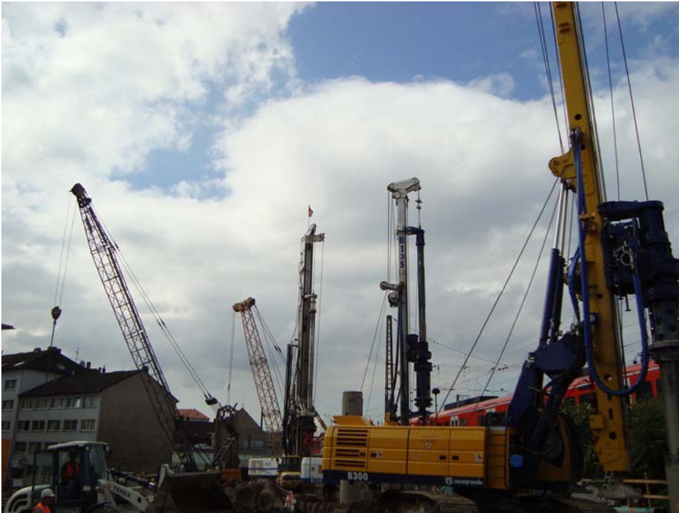
Bild 13: Bohrfahlherstellung
