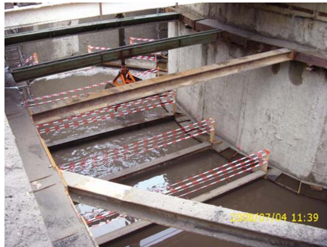
Bild 9: Aussteifung und Unterwasseraushub der Baugrube Pumpenraum
