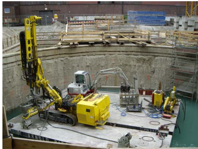
Bild 10: Auftriebspfahlherstellung für Sinterbrunnen
