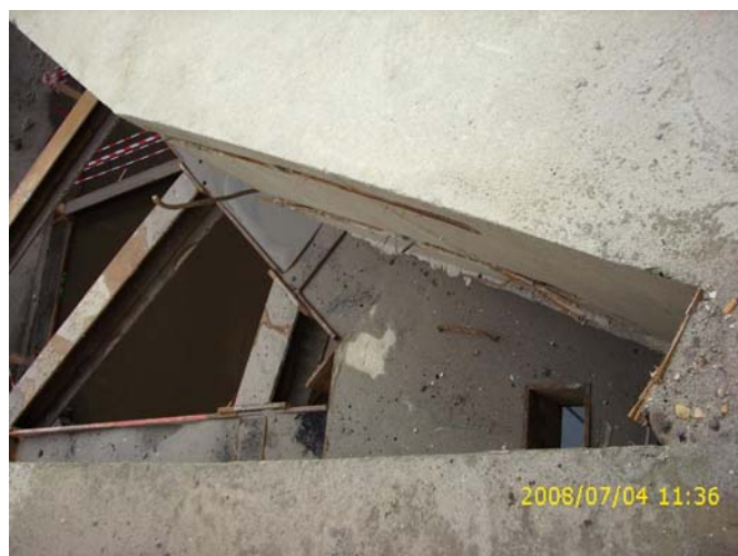
Bild 8: Stahlbetonzwickel zur Übertragung der Drucklasten zwischen den Schlitzwänden und der Aussteifung
