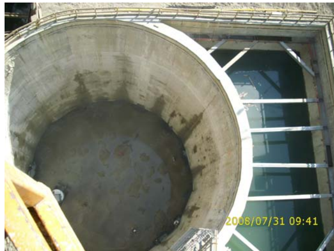
Bild 11: Sinterbrunnen mit Unterwasserbetonsohle, Pumpenraum vor Unterwasseraushub
