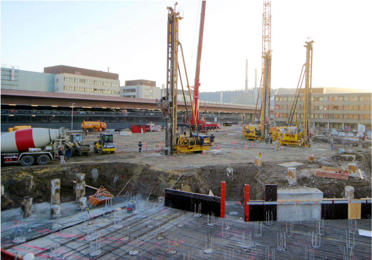
Bild 8: Pfahlherstellung für das Museumsgebäude
