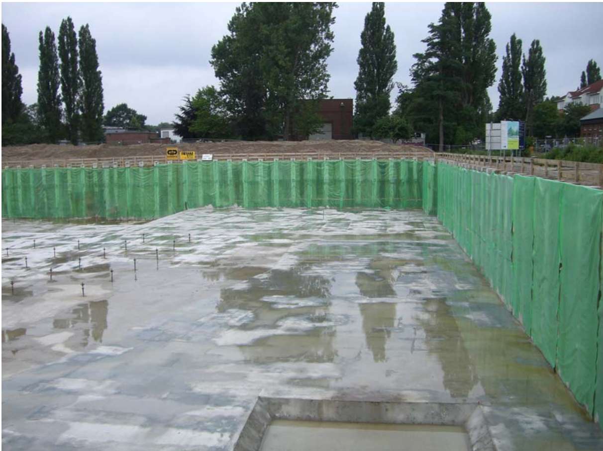
Bild 3: Baugrube nach Fertigstellung
