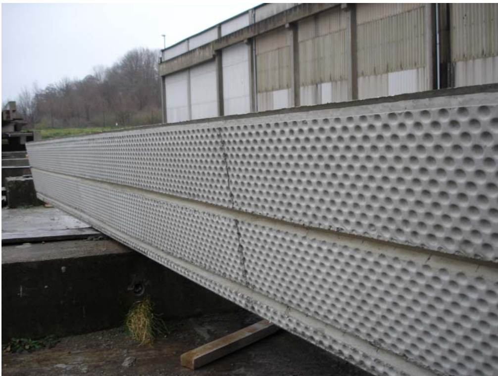
Bild 10: Oberfläche der eingesetzten Fertigteilelemente
