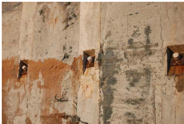
Bild 12: Fertigteil mit Auflagertasche zur Aufnahme des Ankerkopfes
